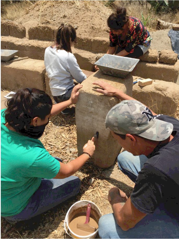
Taller comunitario de reparación de estructuras con tepetate en Tlaxco, Tlaxcala.
