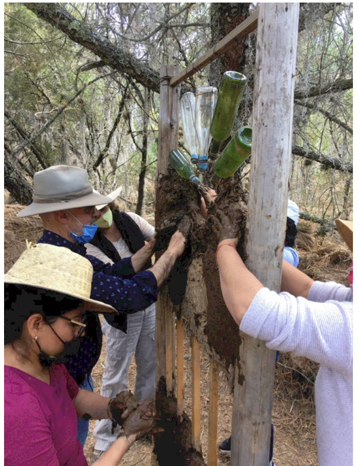
Taller de bioconstrucción en el Proyecto San Isidro, Tlaxco, Tlaxcala.
