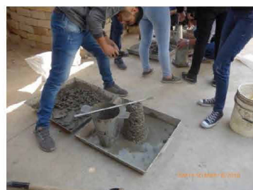
Prueba de revenimiento
