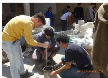
Colado de cilindros
